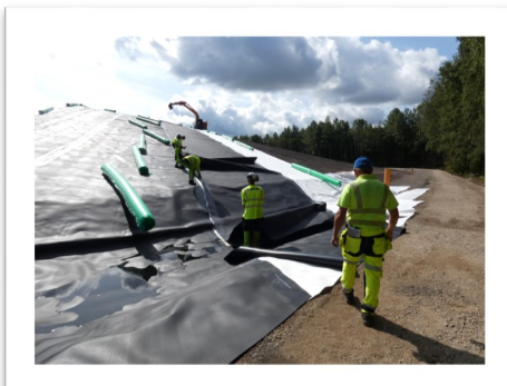
Sluttäckning av ÅVC.
